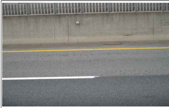
교면포장 상행선 S1 라벨링
