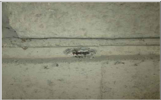
교대 상행선 A1 콘크리트 국부 탈락 및 철근노출
