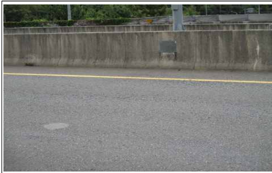
교면포장 상행선 S3 라벨링
